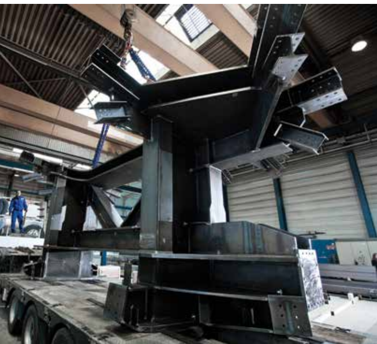
Damit die passenden Bauteile zur richtigen Zeit an den Hauptbahnhof Wien geliefert werden konnten, erstellte Unger aus den umfangreichen Informationen in Tekla Structures die entsprechenden Transportlisten. © Renée Del Missier/Unger Steel Group
