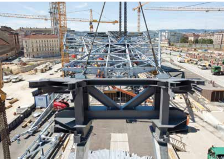
Montage hoch über den künftigen Bahngleisen. © Renée Del Missier/Unger Steel Group
